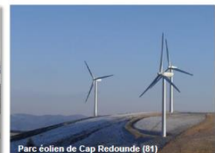
Parc éolien de Cap Redoune (81)
